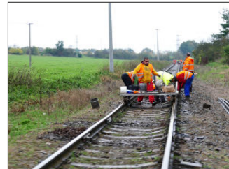
Rekonstrukce železniční trati – foto HN v listopadu 2020
