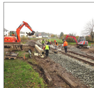
Rekonstrukce přejezdu u hřbitova 10. 11. 2020
