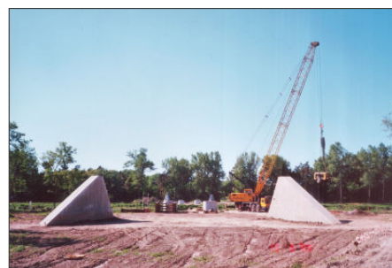
Základy stavby v květnu 2000
