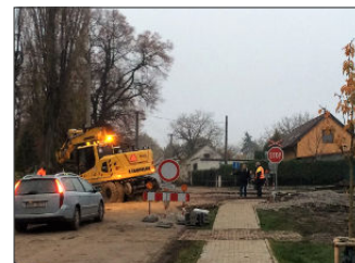
Rekonstrukce přejezdu u hřbitova 6. 11. 2020
