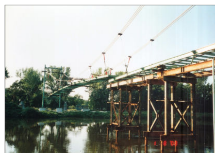
Stavba lávky 1. srpna 2000
