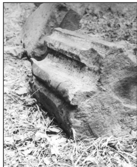
Masivní kus gotického ostění hrádku
